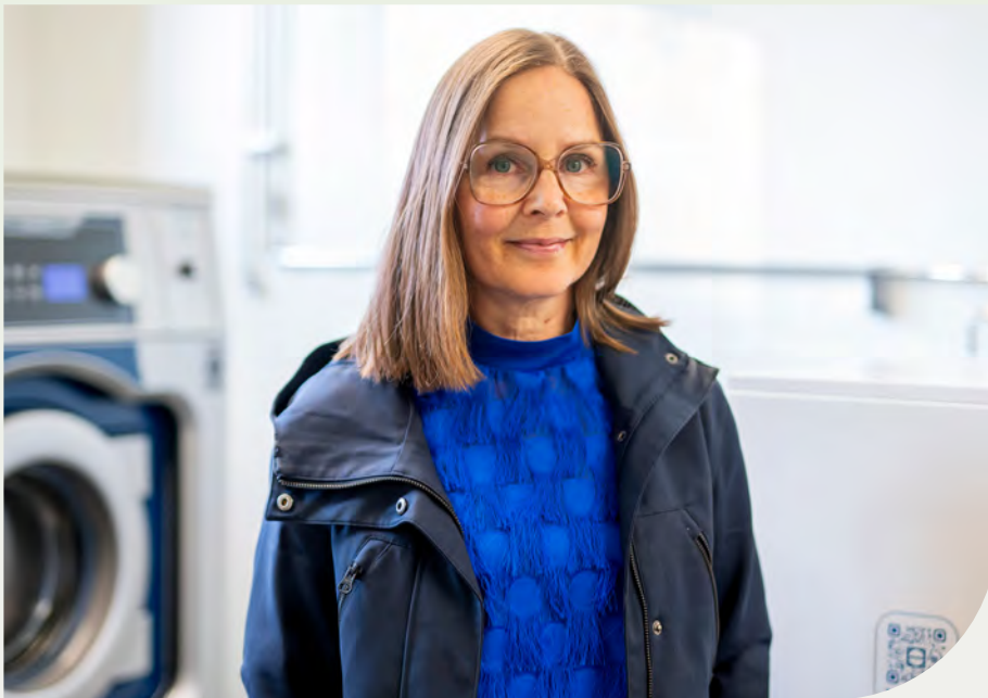
För att försöka minska förbrukningen har Väsbyhem installerat en uppfinning som kallas Mimbox i den nya tvättstugan på Genvägen. Azarina Bäckström, hållbarhetsamordnare på Väsbyhem, visar hur den fungerar.
